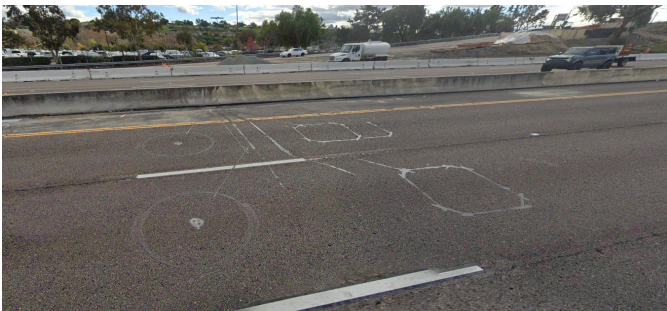
그림 1. 미국 캘리포니아주 샌디에고 카운티의 78 번 고속도로에 설치된 루프 감지기 (loop detector)
