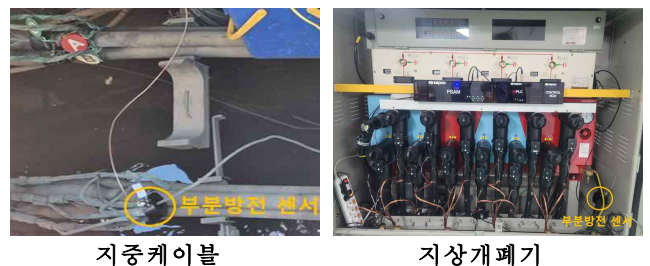
<그림 2. 부분방전 센서 설치>
