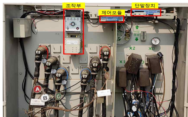
그림4. 부하개폐형 지상변압기 시스템
