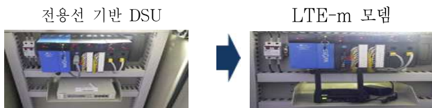
Fig. 4. LTE-m 모뎀을 이용한 통신망 규격변경 전경
